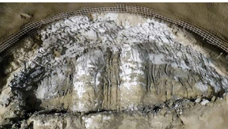
5.2.1: Der große anfallende Tunnelausbruch wird innovativ wiederverwertet.
