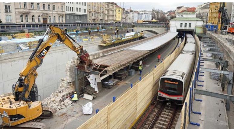
4.2.2: Logistische Herausforderung bei der Knotenstation U2/U4 unter laufendem Betrieb
