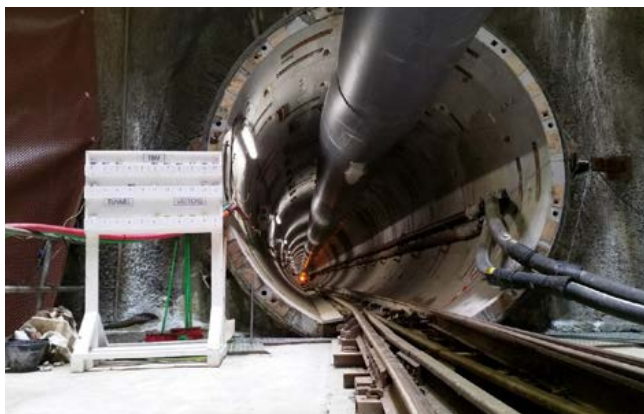
6.2.3 : 10 km langer Abflusstunnel in Doha mit Stahlfasertübbingen
