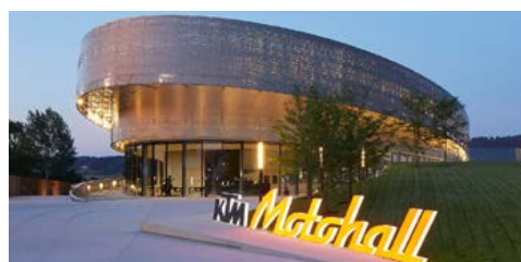
4.1.5: Beim KTM-Museum wird komplett auf Treppen verzichtet und Besucher erreichen alle sechs Ebenen über eine Rampe.
