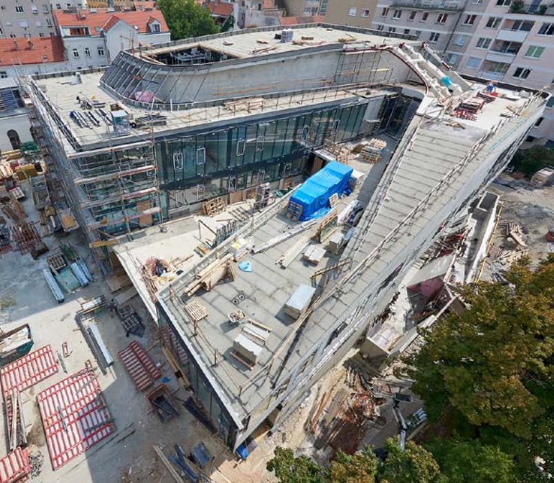
4.1.1: Höchste bauphysikalische Anforderungen im Future Art Lab
