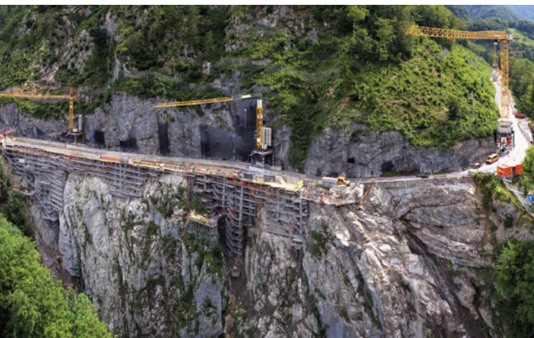
6.2.3: Beim Ausbau Muotathaler Straße musste die zerklüftete ca. 80 m hohe Felswand mit 20 m langen Litzenankern gesichert werden.
