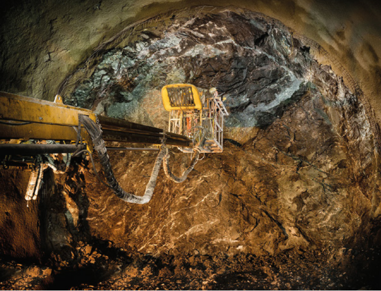
5.2.4: In Baulos KAT3 des Koralmtunnels gibt es alle Verfahren für den Vortrieb, bei der Südröhre gibt es den zyklischen Vortrieb.
