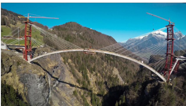
4.2.1: Die Taminabrücke wird ab 2017 die größte Bogenbrücke Europas sein.
