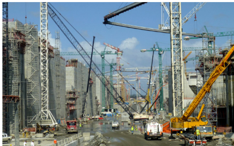
6.2.5: Bei der Erweiterung des Panamakanals musste eine Lebensdauer von 100 Jahren garantiert werden.
