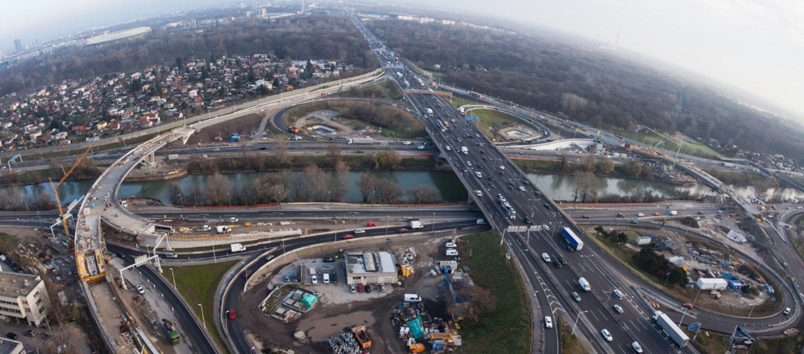
3.2.4: Die besondere Herausforderung bei so viel befahrenen Verkehrsknotenpunkten wie der Wiener Tangente liegt in der Planung der Verkehrsführung.
