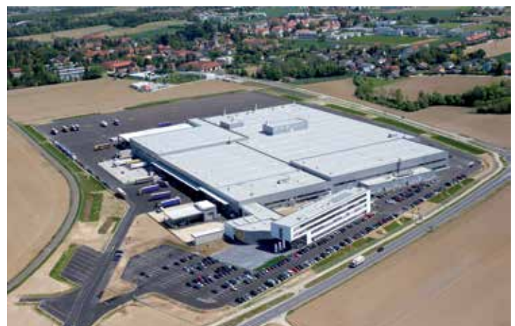
4.1.1: In nur 11 Monaten errichtete Produktionshalle mit 46.500 m 2 und 10.000 m 2 Bürofläche
