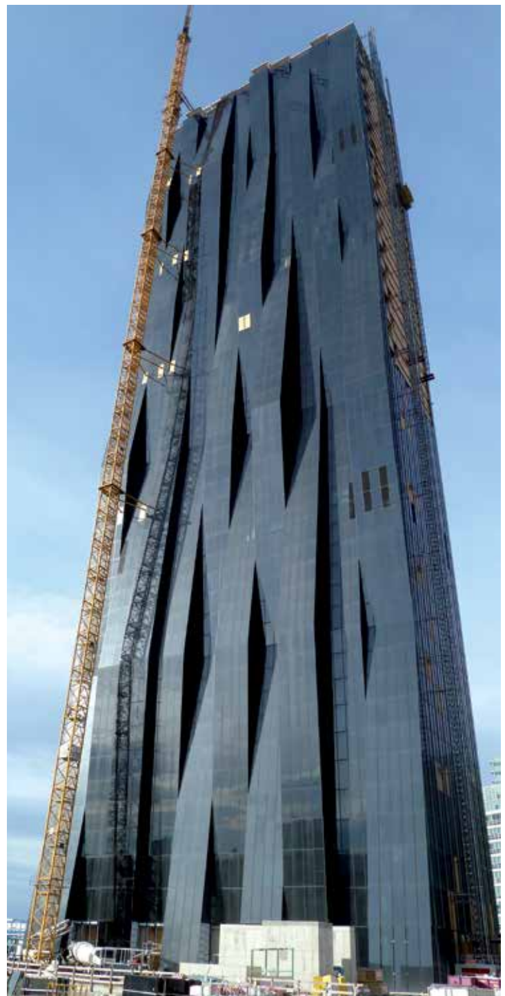
4.1.2: Die spezielle Geometrie sowie die nutzungsbedingten Anforderungen des Investors erforderten zahlreiche innovative Lösungen im Bereich der Fassade des DC-Towers.
