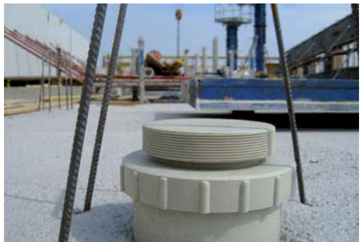
2.3: Deckensensor für onlinebasierende Betonfestigkeitsmessung
