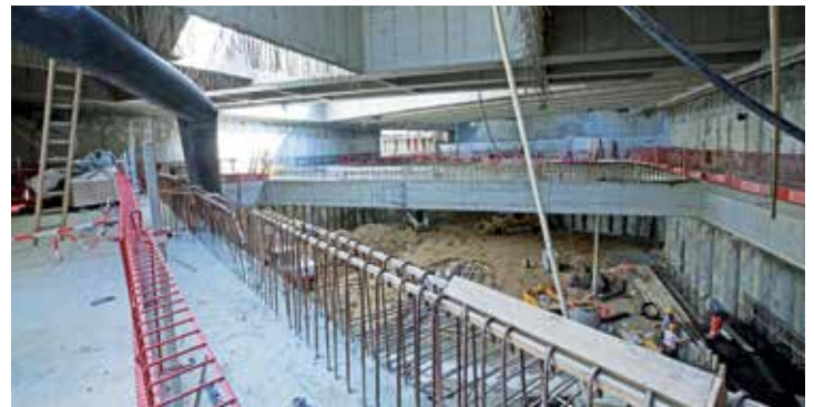
Tiefbauexkursion zur U1/10 Troststraße (E2): Für die Verlängerung der bedeutenden Verkehrsader wird mitten in bewohntem Gebiet gearbeitet.
