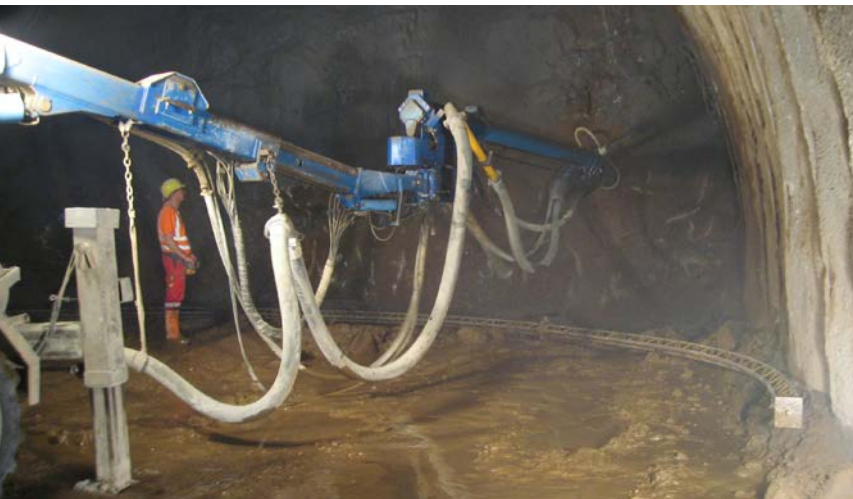
Abbildung 2: Impressionen von großtechnischen Nass-Spritzbetonversuchen
